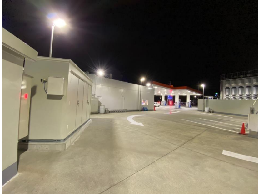
<蓄電システムが導入された ENEOS のサービスステーション>
