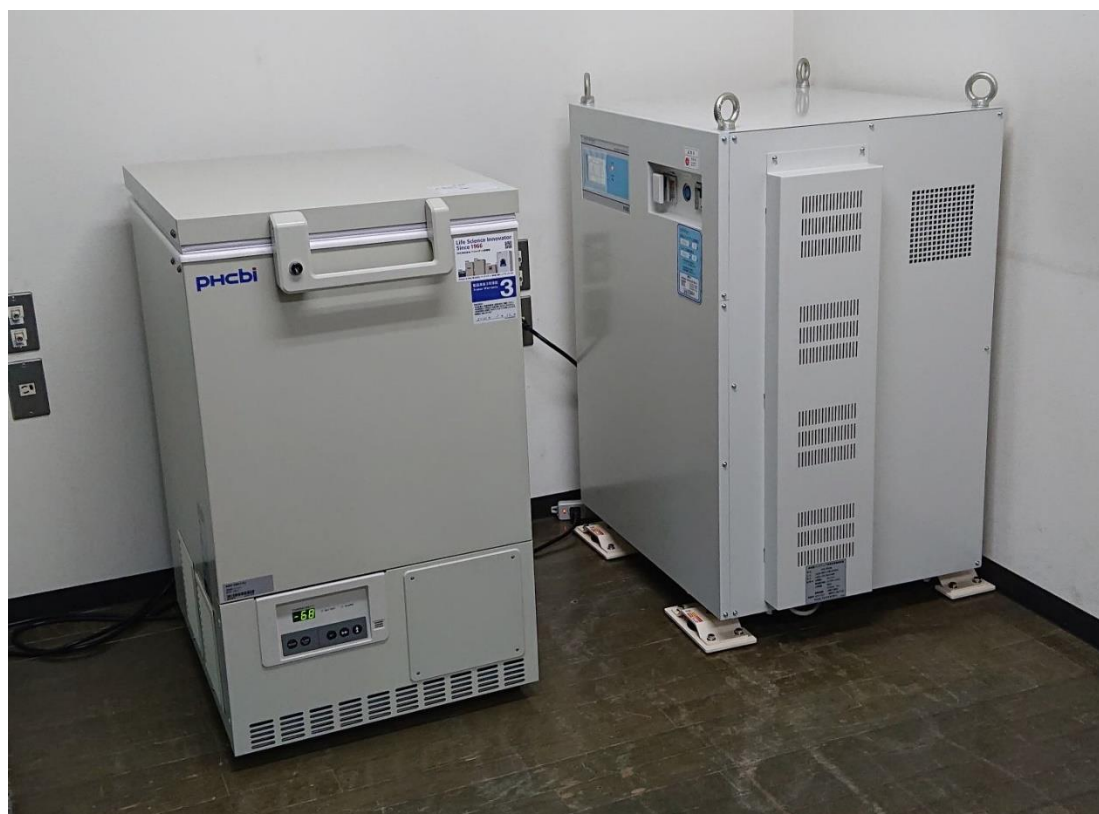
<超低温フリーザー(左)を接続した YSB-5KCM(キャスタータイプ) (右)>
