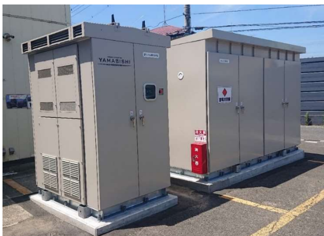
＜神奈川県海老名市の自社工場にて稼働中の蓄電システム「YRW-2000 シリーズ」と太陽光発電＞ パワコン出力 100kW・蓄電池容量 426kWh・太陽光発電 162kW ※試作の為、製品版と異なります
