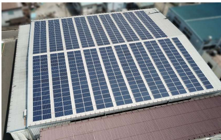
＜神奈川県海老名市の自社工場にて稼働中の蓄電システム「YRW-2000 シリーズ」と太陽光発電＞ パワコン出力 100kW・蓄電池容量 426kWh・太陽光発電 162kW ※試作の為、製品版と異なります
