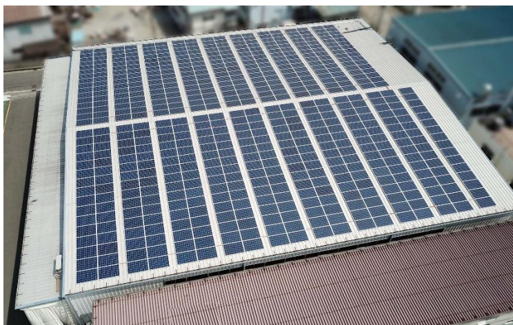
＜神奈川県海老名市の自社工場にて稼働中の蓄電システムと太陽光発電＞ パワコン出力 100kW・蓄電池容量 426kWh・太陽光発電 162kW
