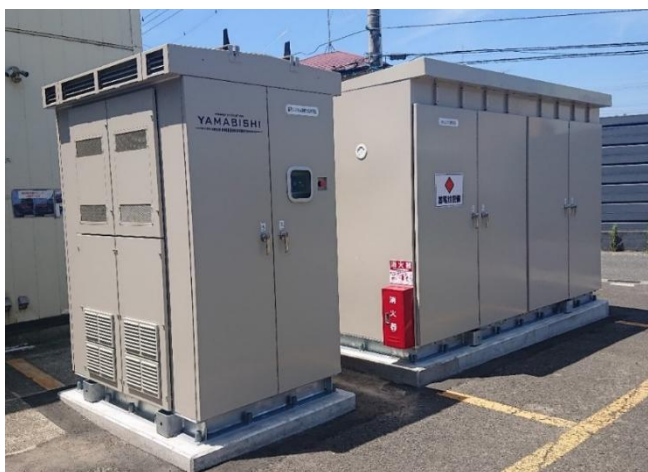
＜神奈川県海老名市の自社工場にて稼働中の蓄電システムと太陽光発電＞ パワコン出力 100kW・蓄電池容量 426kWh・太陽光発電 162kW
